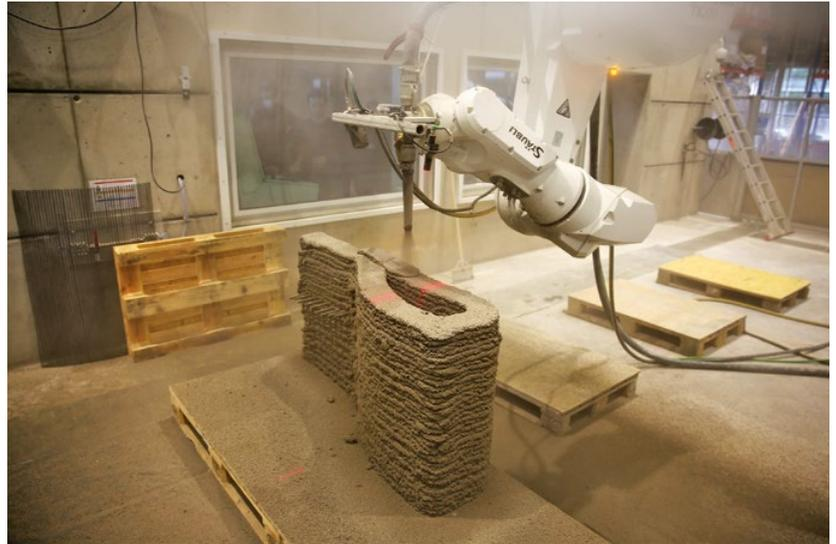
Mit dem robotergestützten Spritzbetonverfahren (Shotcrete 3D Printing) lässt sich eine komplexe Wandkonstruktion auch ohne Schalung fertigen. Sogar eine horizontal andgedruckte, bewehrte Konsole lässt sich damit realisieren. Stahlbewehrung und Textilbewehrung wurden manuell integriert.
