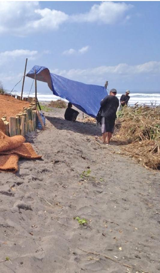
Testbetrieb der Kokosmatten auf Bali: Diese natürlichen Geotextilien sollen die Küste bei Hochwasser vor Erosion schützen.
