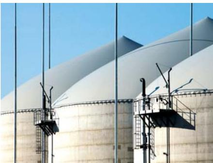
Zur Zwischenspeicherung von Biogas können sich die Hauben auf den Fermentern dynamisch ausdehnen. Um auch die Einspeisung des Gases ins Gasverteilnetz zu verbessern, hat die Technische Universität Clausthal ein neues Verfahren entwickelt und zum Patent angemeldet. Bild: Fotolia
