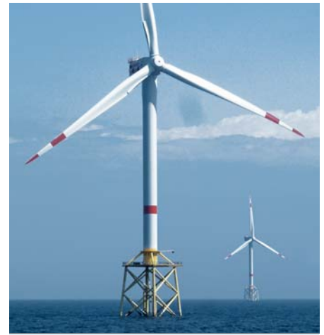
Stählerne Tragkonstruktionen bei Offshore-Windenergieanlagen, wie hier im Windpark alpha ventus, können in Bezug auf Nachhaltigkeit bewertet und optimiert werden. Bild: Bechtel
