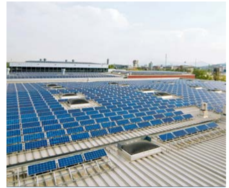
Die Hochschule Emden/Leer arbeitet daran, dass Unternehmen den Strom ihrer Solaranlage direkt in die eigene Produktion einspeisen können.
